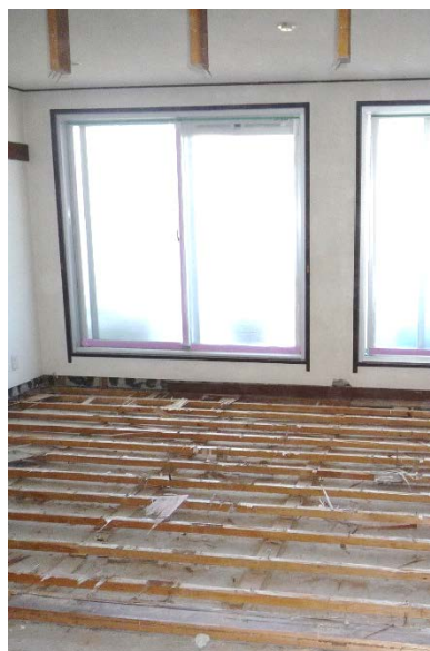
※施工中の様子。
