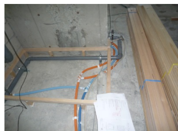
※施工中の様子。
