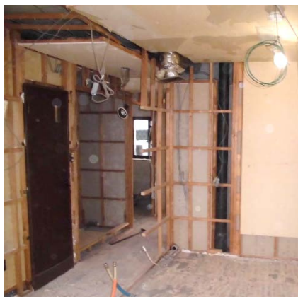
※施工中の様子です。
