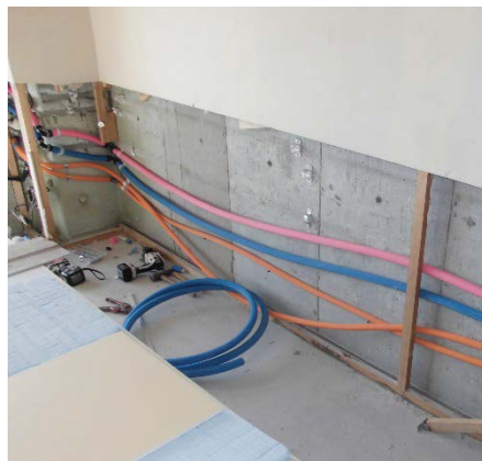
※施工中の様子です。
