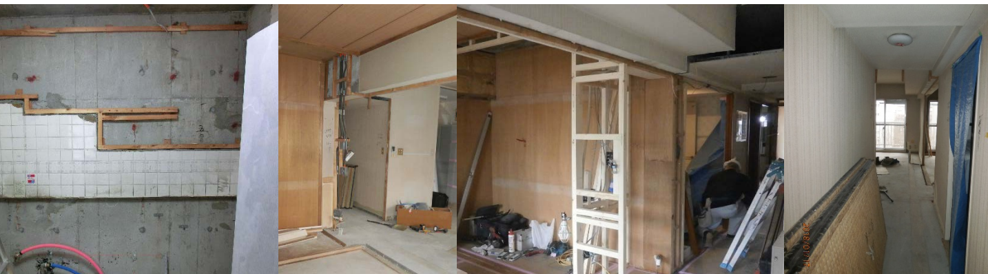
※掲載画像は、見学会開催のお宅の施工中のものです。
