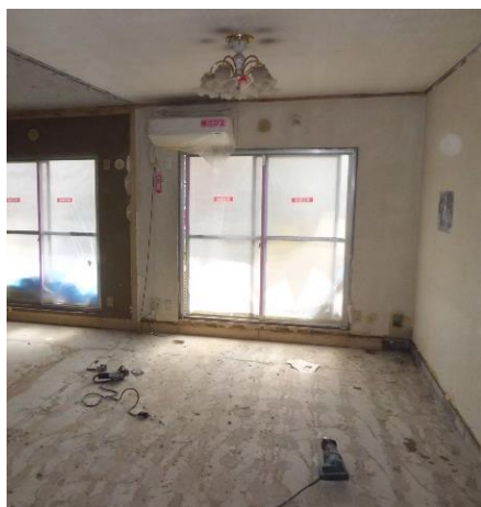
※見学会開催のお宅の施工中のものです。
